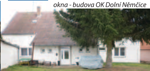
okna - budova OK Dolní Němčice
