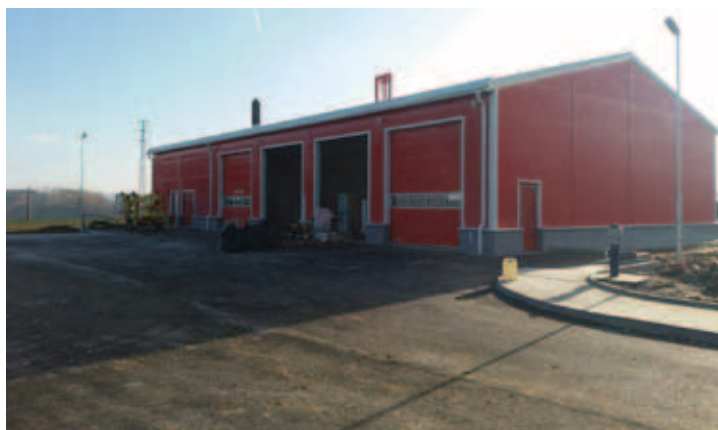
výstavba hasičské zbrojnice SDH Dačice
