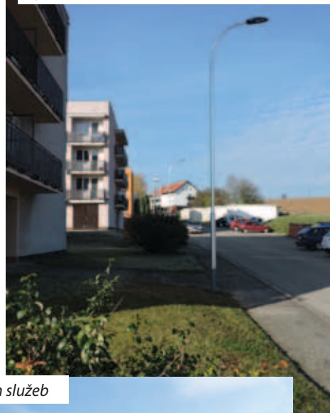
výměna veřejného osvětlení v ul. U Stadionu
